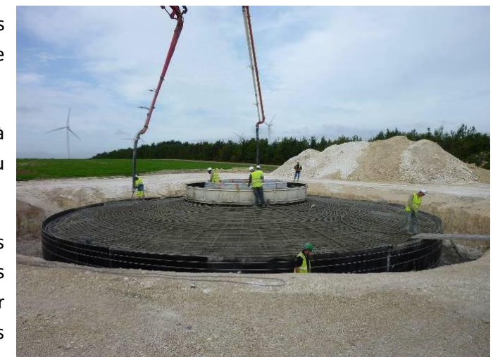
Photo 1. Construction d'une fondation
